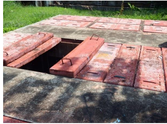
สภาพบ่อดักน้ำเสียประตูเหล็ก (CSO ๑)
