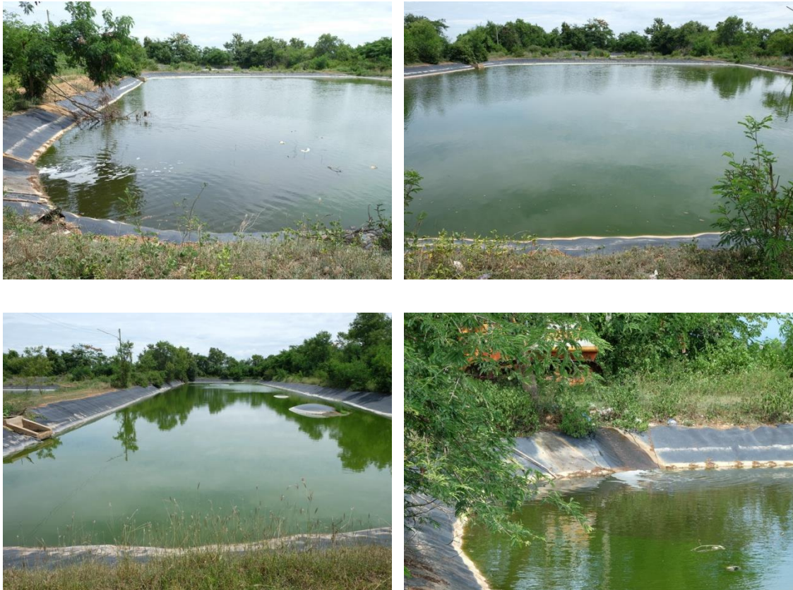
สภาพบ่อบำบัดน้ำชะขยะ
