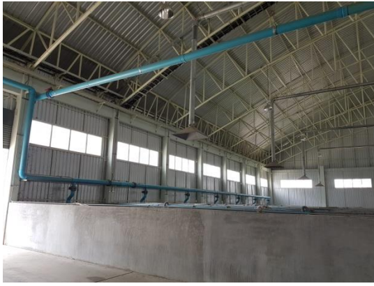
ท่อควบคุมแก๊สและความร้อนในช่องหมักปุ๋ย
